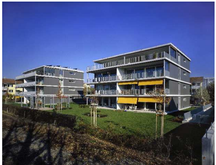
Süd-West-Fassade vom alten Bahndamm
