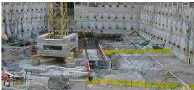
Baugrube mit rückverankerter Rühlwand und Grundwasserabsenkung
