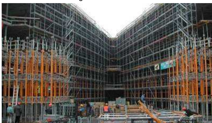
Ost- und Westflügel im Rohbau
