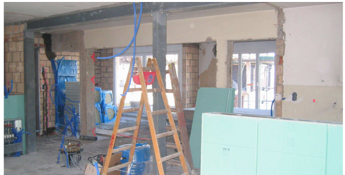
grosszügigere Wohnungsgrundrisse dank Wandausbrüchen
