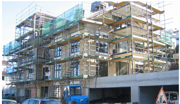
Ende Rohbau Februar 2007
