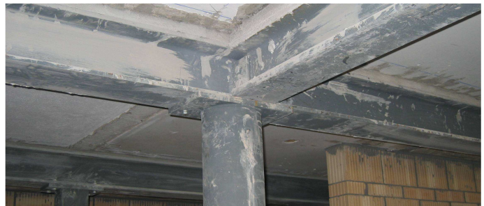
Detail neu eingebaute Stahlträger und Stützen
