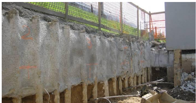
bis auf Ankerlage ausgehobene Mikropfahlwand
