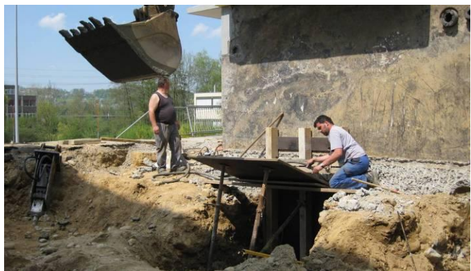
Erste Unterfangungsetappe des Nachbargebäudes
