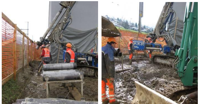
Bohren und betonieren der Mikropfahlwand
