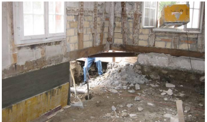
Erneuerung Sockelmauer, Unterfangung Nordfassade
